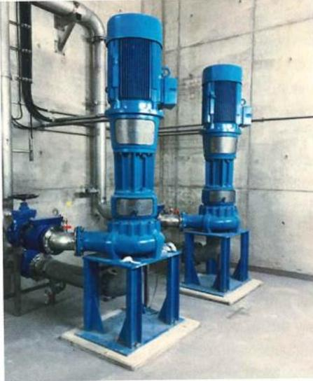
**Bild 5** Die Abwasserpumpen im Pumpwerk Kleinottweiler können mithilfe der künstlichen Intelligenz auf Anomalien bei den Betriebsgeräuschen überprüft werden.
